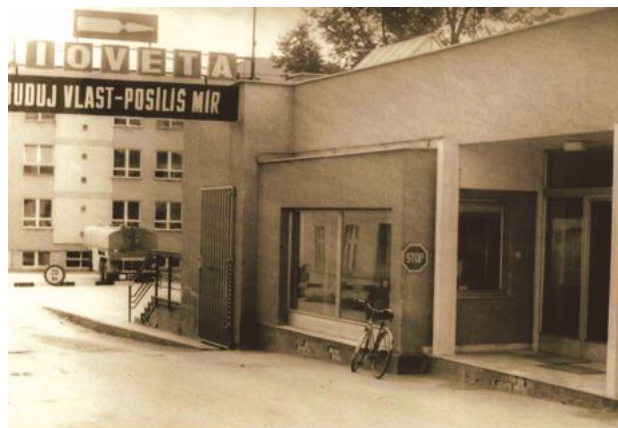
Casa portarului Bioveta, Ivanovice na Hané din 1971
