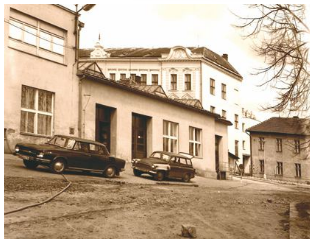
Construirea primei camere operaționale – aici s-a desfășurat liofilizarea după 1960
